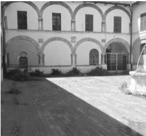
Figura 15 Teramo. Convento di Sant'Antonio. Chiostro
