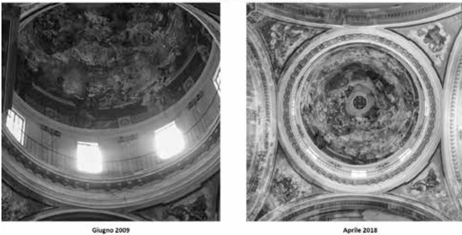
Figura 7 Incremento del degrado degli affreschi della cupola (2009-2018)
