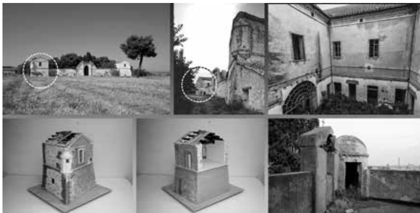
Figura 6 Casina fortificata della Penna, Vasto. Particolari: garitte, corte, portone d'ingresso
