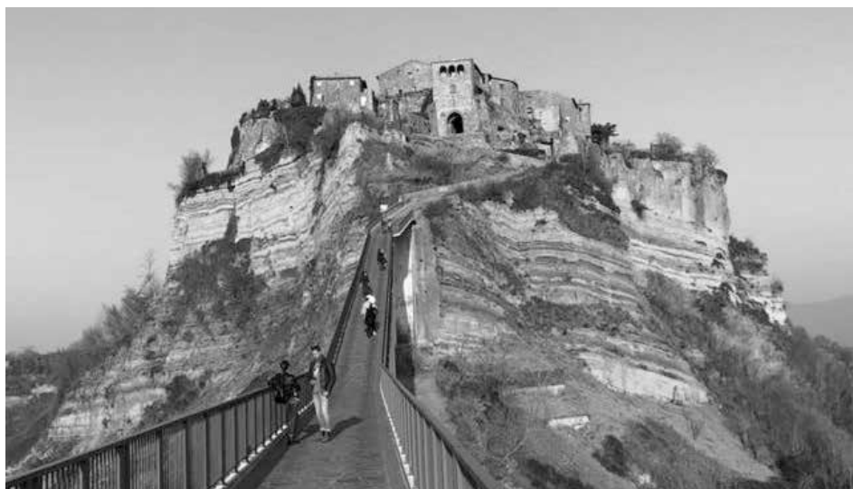
Foto 1 Civita – il ponte di ingresso al borgo
