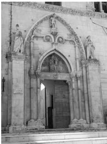
Figura 22 Sulmona (AQ). Portale del complesso della SS. Annunziata
