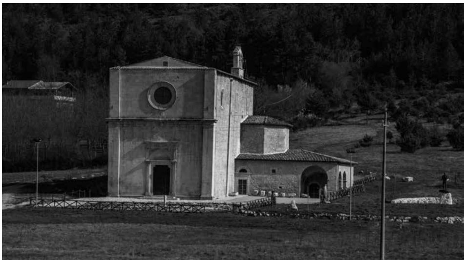
Figura 6 La chiesa di Santa Maria di Cinturelli (Aq). Foto dell'autore, 2022
