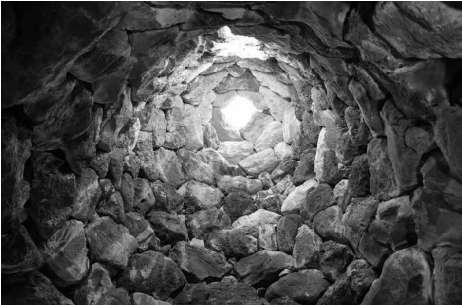
Figura 7 Trullo abruzzese: particolare della copertura. Foto di Lucia Serafini, 2023
