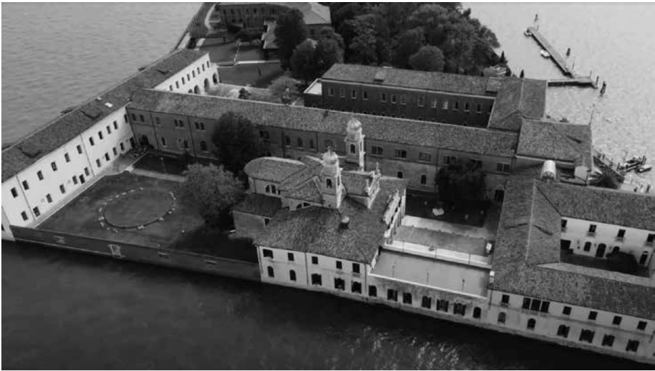
Figure 1-2 Isola di San Servolo (Ve), Centro di formazione, viste dall'alto
